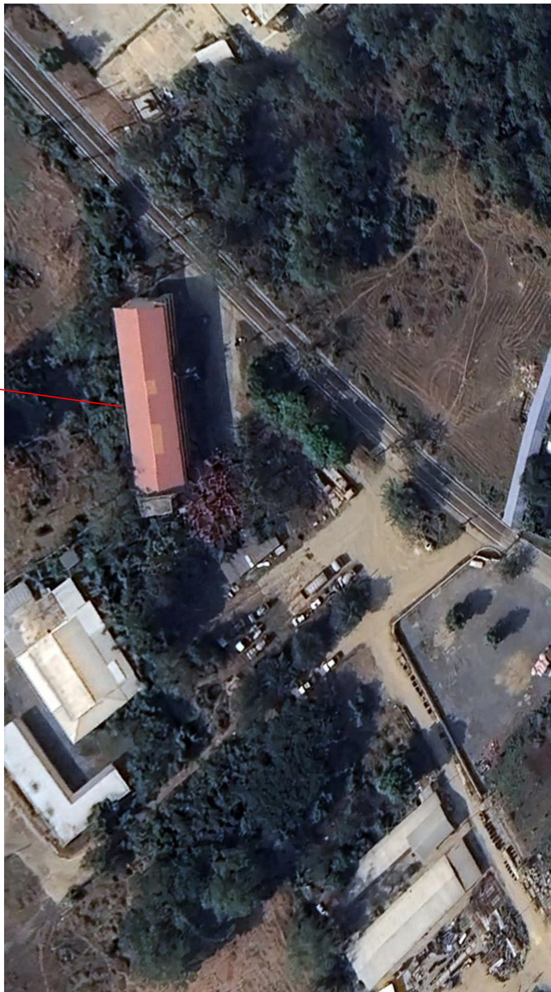
อาคารบ้านพักข้าราชการตำรวจ แฟลต 4 ชั้น 30 ห้อง (แฟลตแม่ปูคา)
